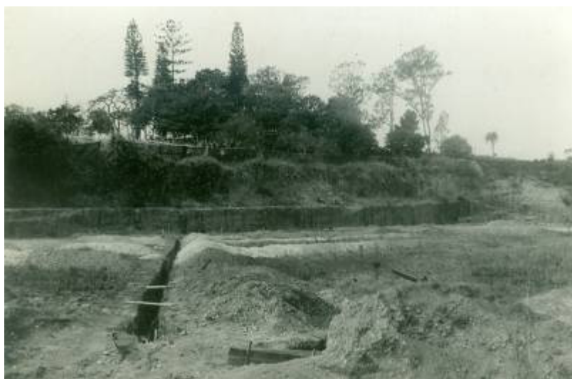
FIGURA 2: Construção do Campo de Foot-ball do Ginásio (1913-1915) FONTE: ACERVO FOTOGRÁFICO DO COLÉGIO CATARINENSE
